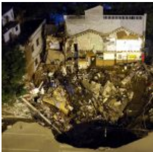
Chine : un énorme sinkhole avale plusieurs commerces à Guangzhou
