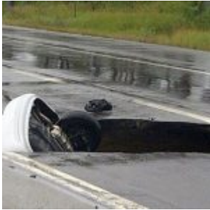
Canada : un « sinkhole » avale une voiture
