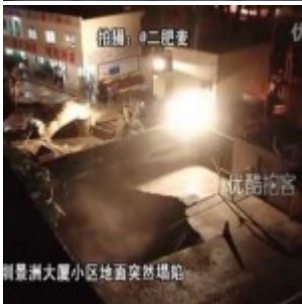
Chine : une doline d'effondrement fait une [autre] victime
